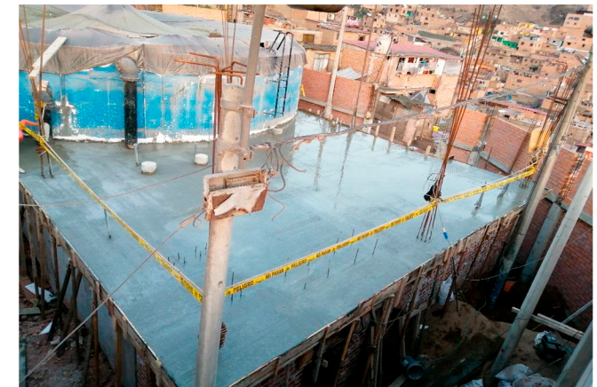
CONSTRUCCION DE CASETA 2 NIVELES R 836
