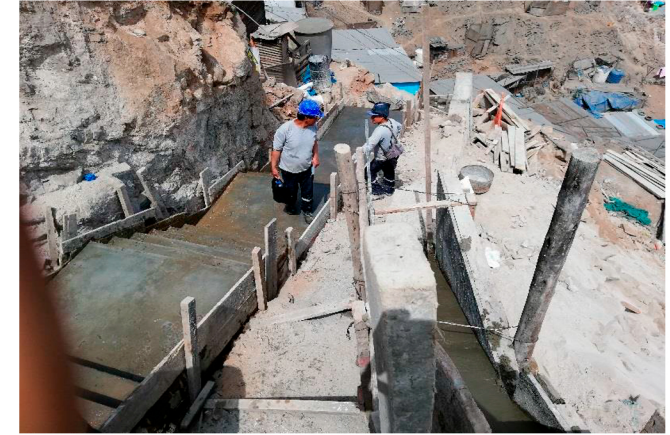
CONSTRUCCIÓN DE GRADERIA TRAMO 1 RAP 01
