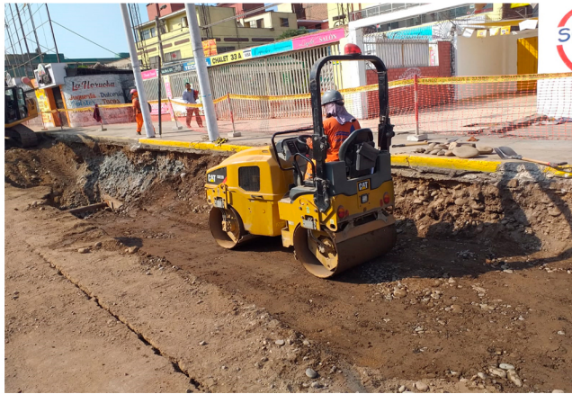
CONSTRUCCIÓN DE OBRAS CIVILES
