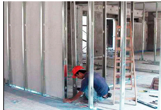
TABIQUERÍA Y DRYWALL
