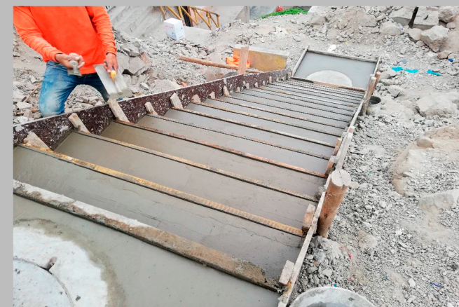
LLENADO DE ESCALERA REPLANTEADA f''=175\text{kg/cm}^2
