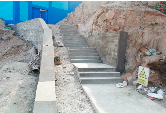
CONSTRUCCIÓN DE GRADERIA TRAMO 2 RAP 01
