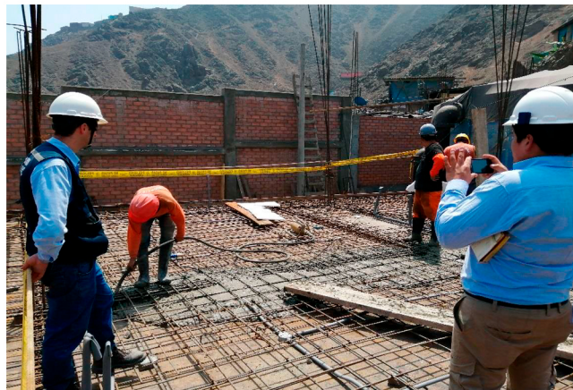
CONSTRUCCION DE CASETA 2 NIVELES R 836
