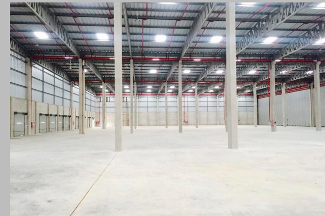
CONSTRUCCIÓN DE LOSAS PARA ALMACÉN
