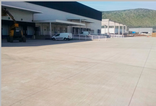
PAVIMENTACIÓN DE PATIO DE MANIOBRAS
