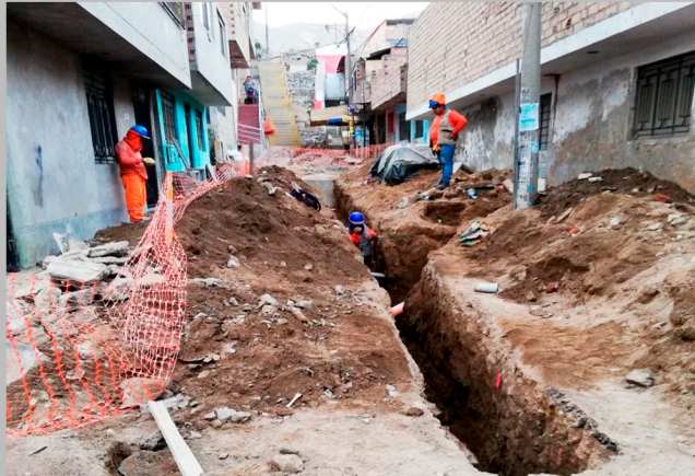
REPOSICION DE ALCANTARILLADO CON SUS RESPECTIVAS CONECCIONES TRAMO 2
