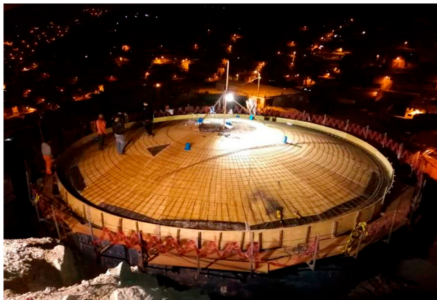
MEJORAMIENTO Y CONSTRUCCIÓN DE CÚPULA R-833
