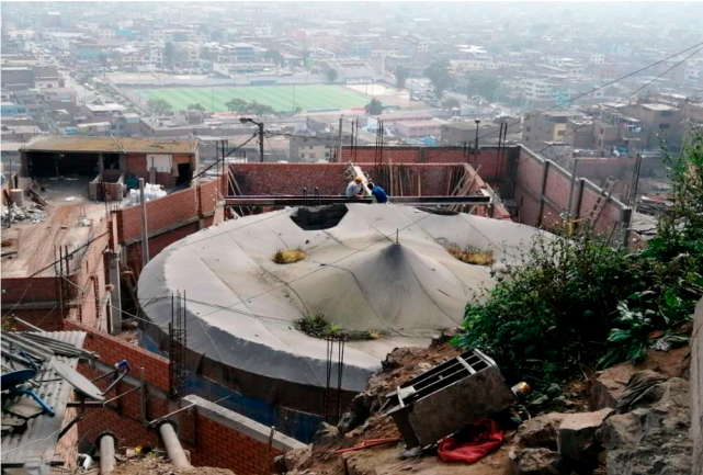
CONSTRUCCIÓN DE CERCO DE RESERVORIO R-835
