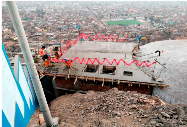
CONSTRUCCION DE CASETA 2 NIVELES R 836
