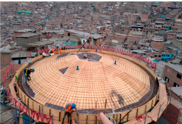
MEJORAMIENTO Y CONSTRUCCIÓN DE CÚPULA R-833
