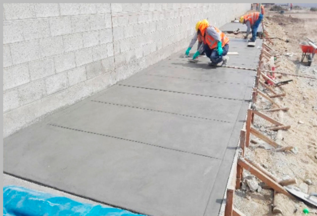
CONSTRUCCIÓN DE VEREDA DE CONCRETO
