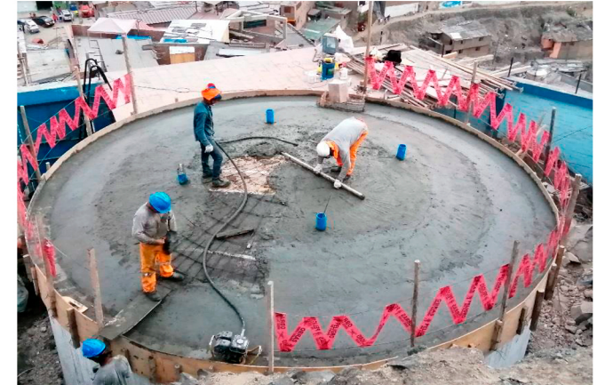
CONSTRUCCIÓN DE CÚPULA R-2
