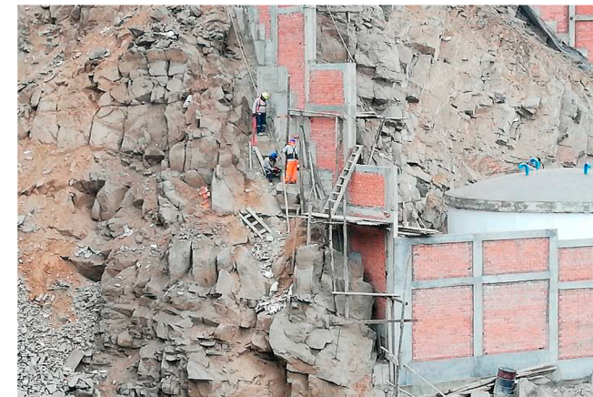
CONSTRUCCIÓN DE CERCO PERIMÉTRICO RAP 01
