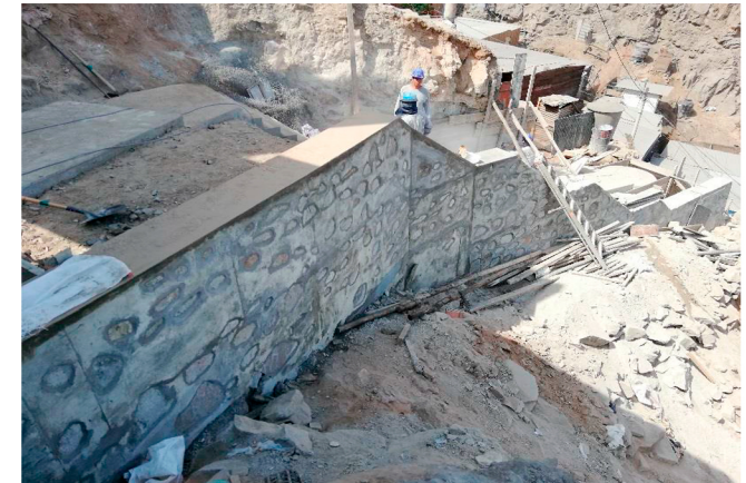
CONSTRUCCIÓN MURO ENVOQUILLADO TRAMO 1 DEL RAP 01
