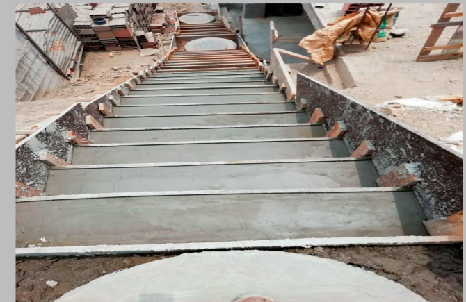
REPOSICION DE ESCALERAS EN TRAMOS TRABAJADOS EN LA INSTALACIÓN DE ALCANTARILLADO Y AGUA POTABLE
