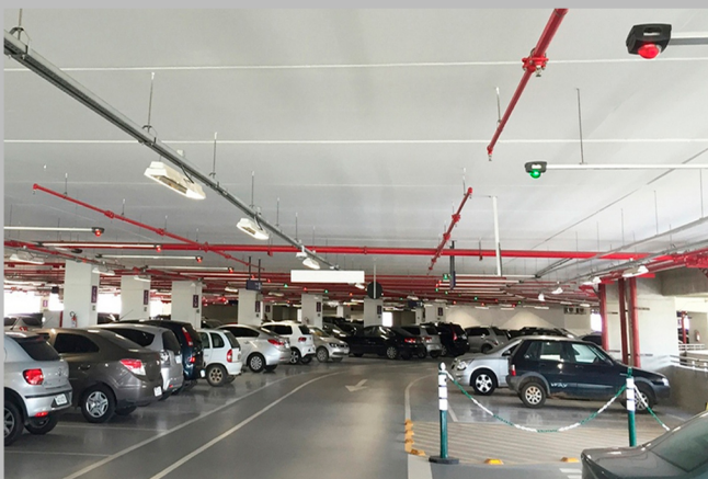
CONSTRUCCIÓN DE ESTACIONAMIENTO VEHICULAR
