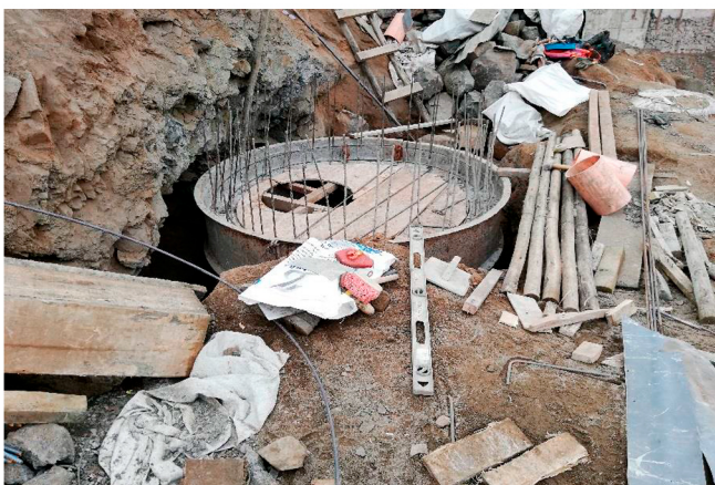
CONSTRUCCIÓN DE CÁMARAS DE VALVULAS DE AIRE Y PURGA
