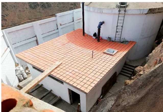
INSTALACIÓN DE LADRILLO PASTELERO RAP 01
