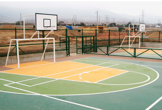
CONSTRUCCIÓN DE LOSA DE CONCRETO COLOREADA
