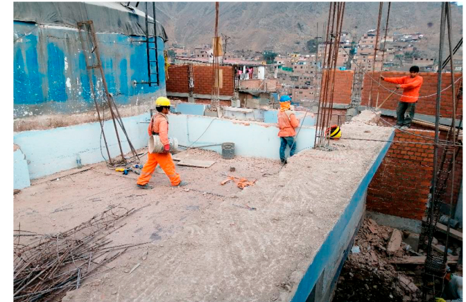
CONSTRUCCION DE CASETA 2 NIVELES R 836
