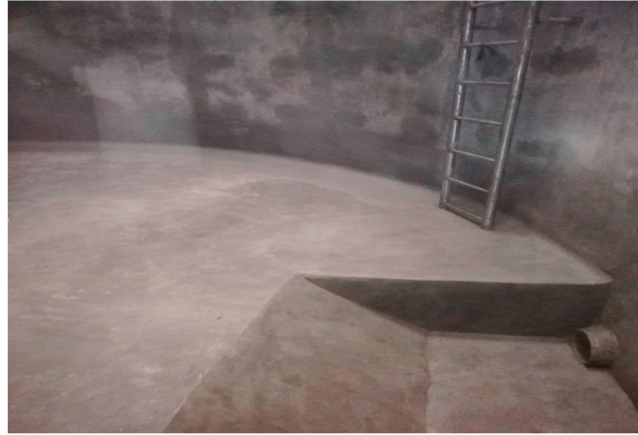
CONSTRUCCIÓN DE SOBRE PISO SEMIPULIDO DEL RAP 01
