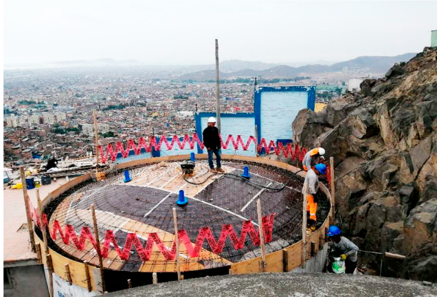
CONSTRUCCIÓN DE CÚPULA R-2
