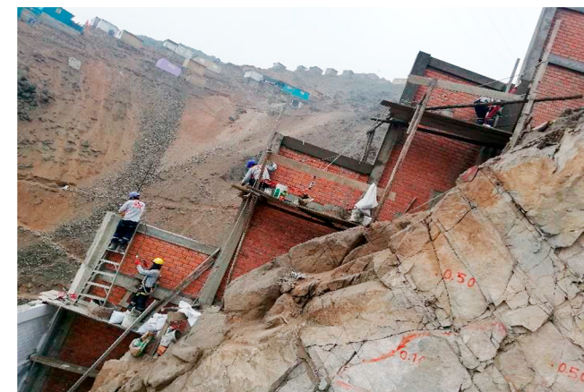
CONSTRUCCIÓN DE CERCO PERIMÉTRICO RAP 01
