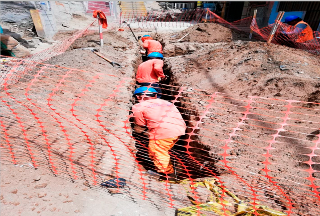
REPOSICIÓN DE ALCANTARILLADO CON SUS RESPECTIVAS CONECCIONES TRAMO 1
