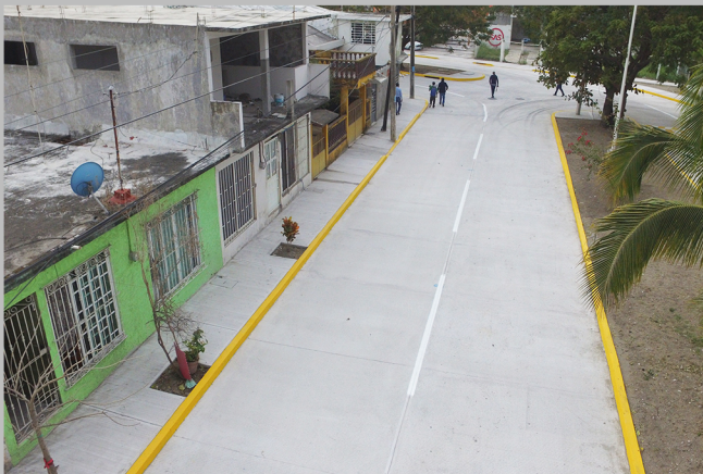
PAVIMENTACIÓN DE PISTAS DE CONCRETO
