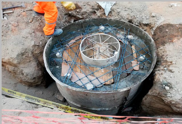
CONSTRUCCIÓN DE TECHO PARA BUZÓN
