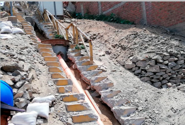
INSTALACIÓN DE TUBERIAS DE ALCANTARILLADO Y LA CONSTRUCCIÓN DE RESPECTIVAS BUZONETES
