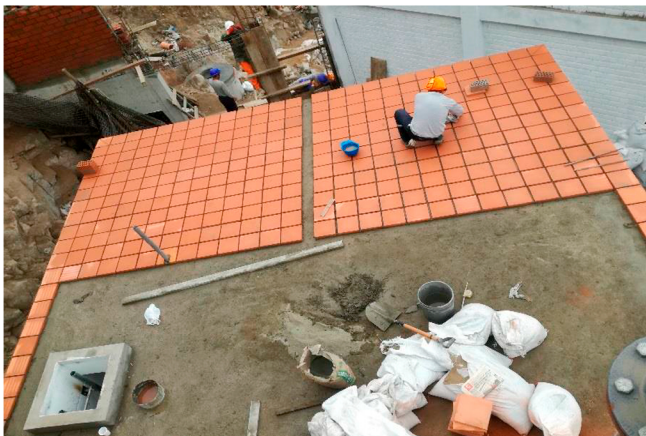
INSTALACIÓN DE LADRILLO PASTELERO RAP 01
