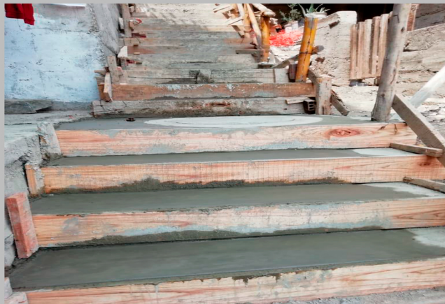
REPOSICION DE ESCALERAS EN TRAMOS TRABAJADOS EN LA INSTALACIÓN DE ALCANTARILLADO Y AGUA POTABLE
