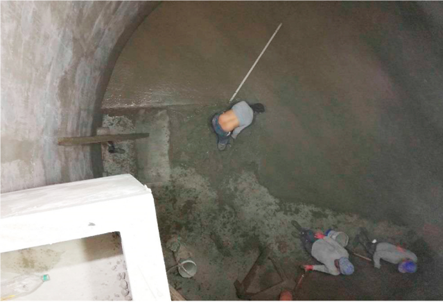
CONSTRUCCIÓN DE PISO SEMIPULIDO DEL RAP 01
