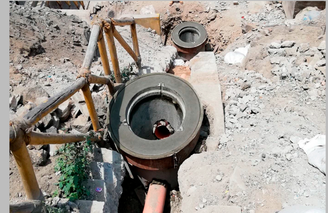
INSTALACIÓN DE TUBERIAS DE ALCANTARILLADO Y LA CONSTRUCCIÓN DE RESPECTIVAS BUZONETES
