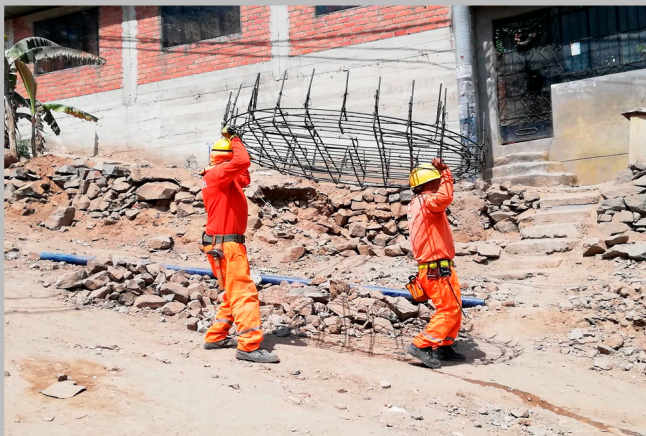
ACARREO DE PARRILLA DE CÁMARAS
