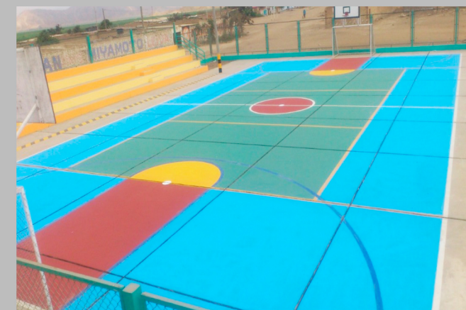
CONSTRUCCIÓN DE LOSA DEPORTIVA DE CONCRETO
