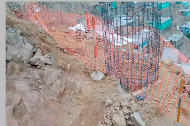
CONSTRUCCIÓN DE LA ESTRUCTURA DE ACERO PARA CÁMARAS
