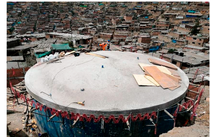
MEJORAMIENTO Y CONSTRUCCIÓN DE CÚPULA R-833
